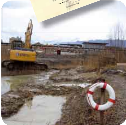
Abenteurliche Vorarbeiten in der Kiesgrube Es entstehen wieder natürliche Lebensräume.
