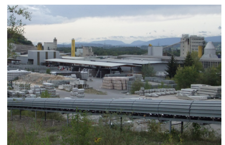
Betriebsareal mit Kieswerk (rechts)
